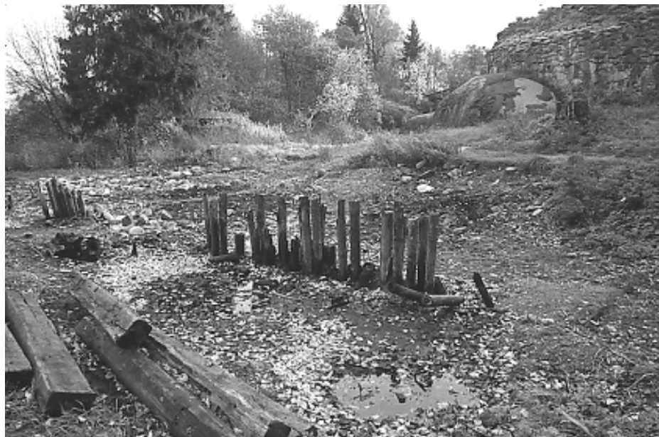
Landhöjningen har torrlagt slotts-fjärden runt Raseborg. Tjälén har tryckt upp pålstråk ur jorden på borgens norra sida. Pålarna härstammar från 1420-talet. Foto Harry Alopaeus.
